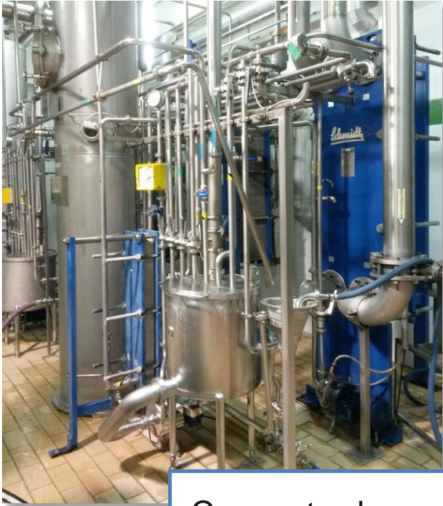
Concentradores de placas
