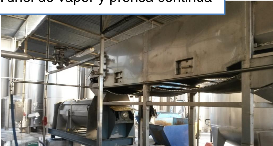
Túnel de vapor y prensa continua
